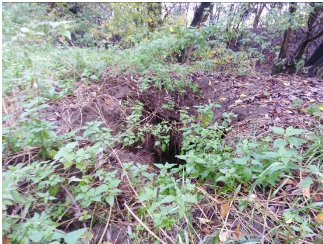
Fotografie 5 - Propad tělesa PB hráze
