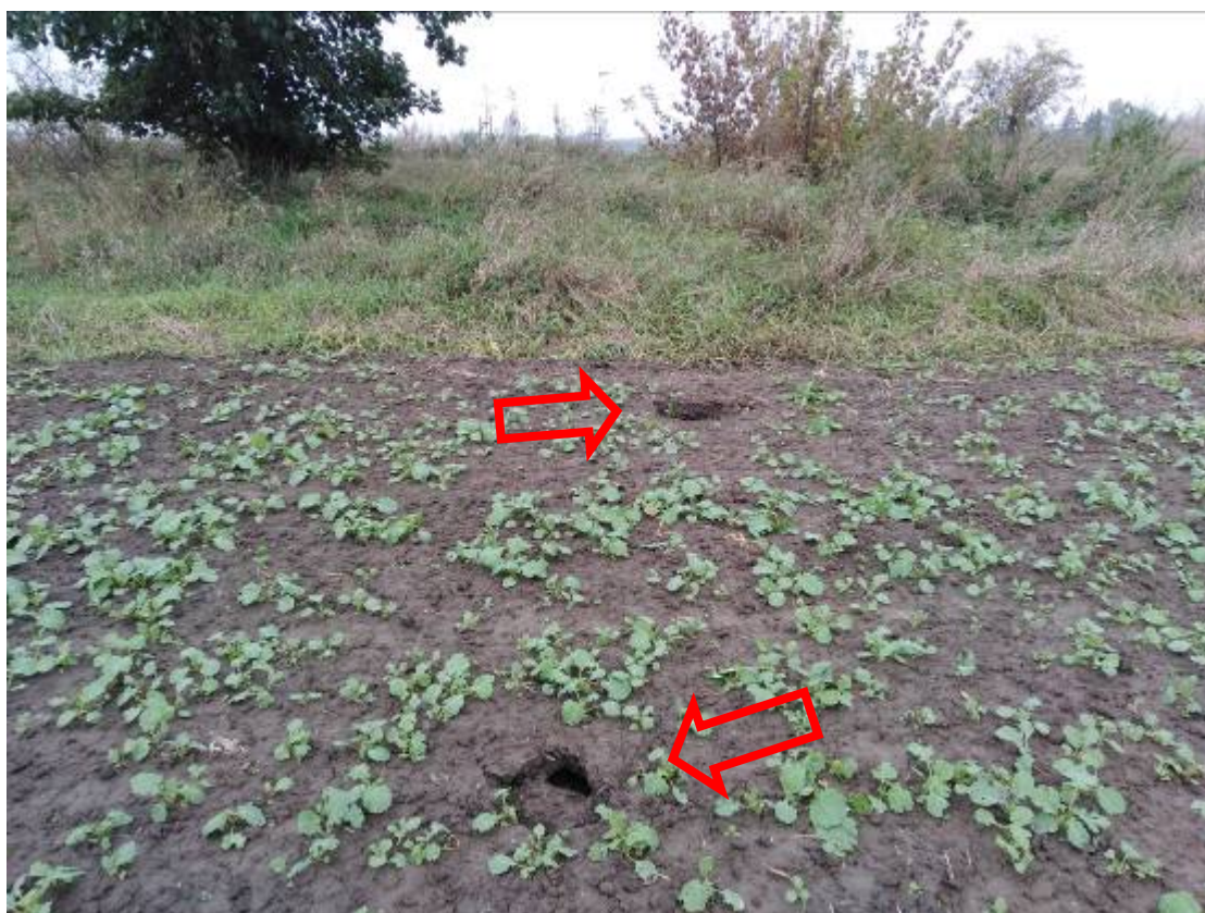
Fotografie 6 – Dvě propadlá místa (označené šipkou) v polním pozemku při PB hrázi nad obcí Bystročice
