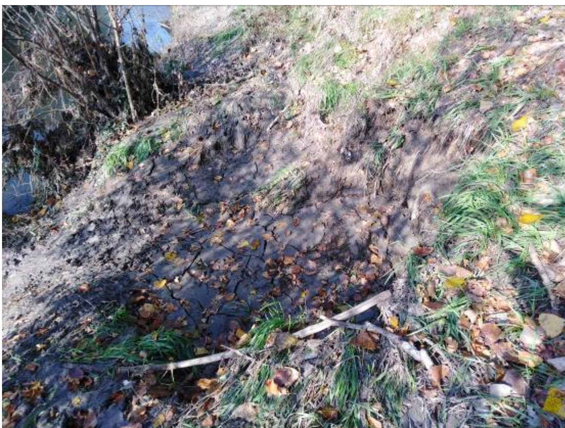
Fotografie 10 – Propad části LB návodního svahu (a břehu)
